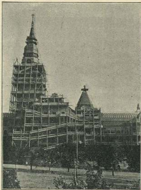
A városház építés alatt
