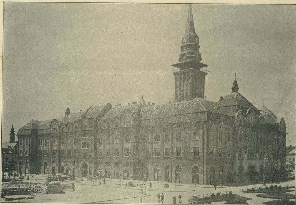
A Csokonai-téri homlokzat
